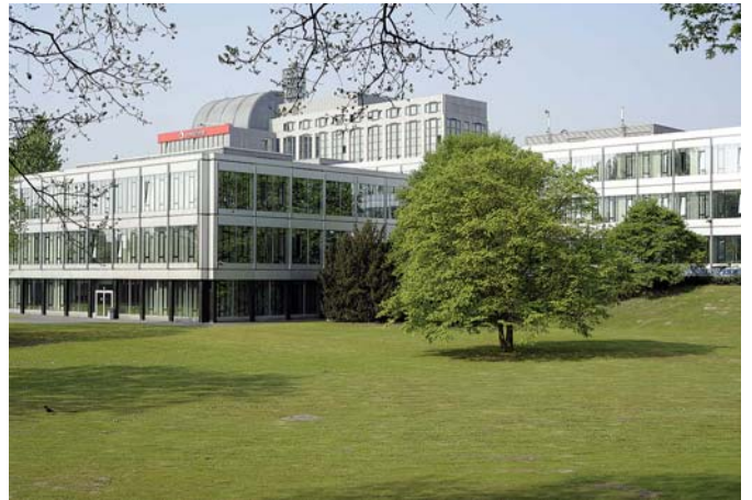
Haus am Seestern (ehemalige Horten-Hauptverwaltung)
