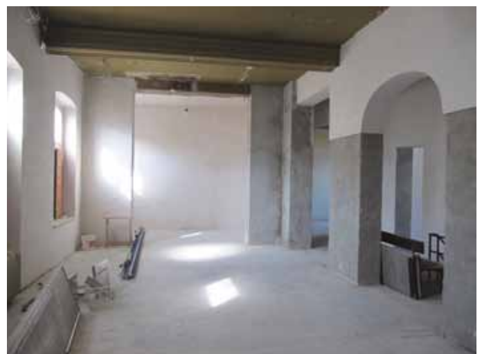
Noch eine Baustelle: Die Räume des späteren Museums
