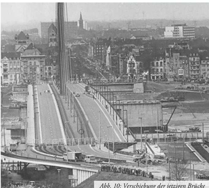
Abb. 10: Verschiebung der jetzigen Brücke
